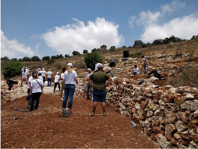
Ein kleiner Blick auf unser Tageswerk (Mauer rechts).
